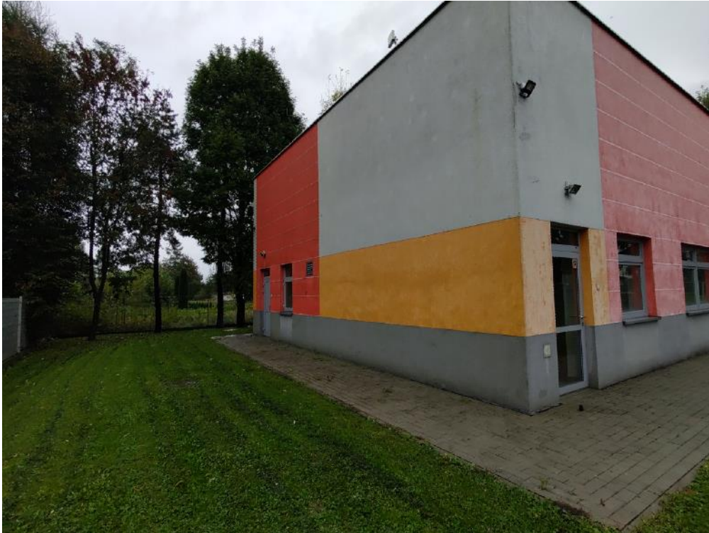
Tylna elewacja kotłowni GO (północna lub północno-zachodnia)
