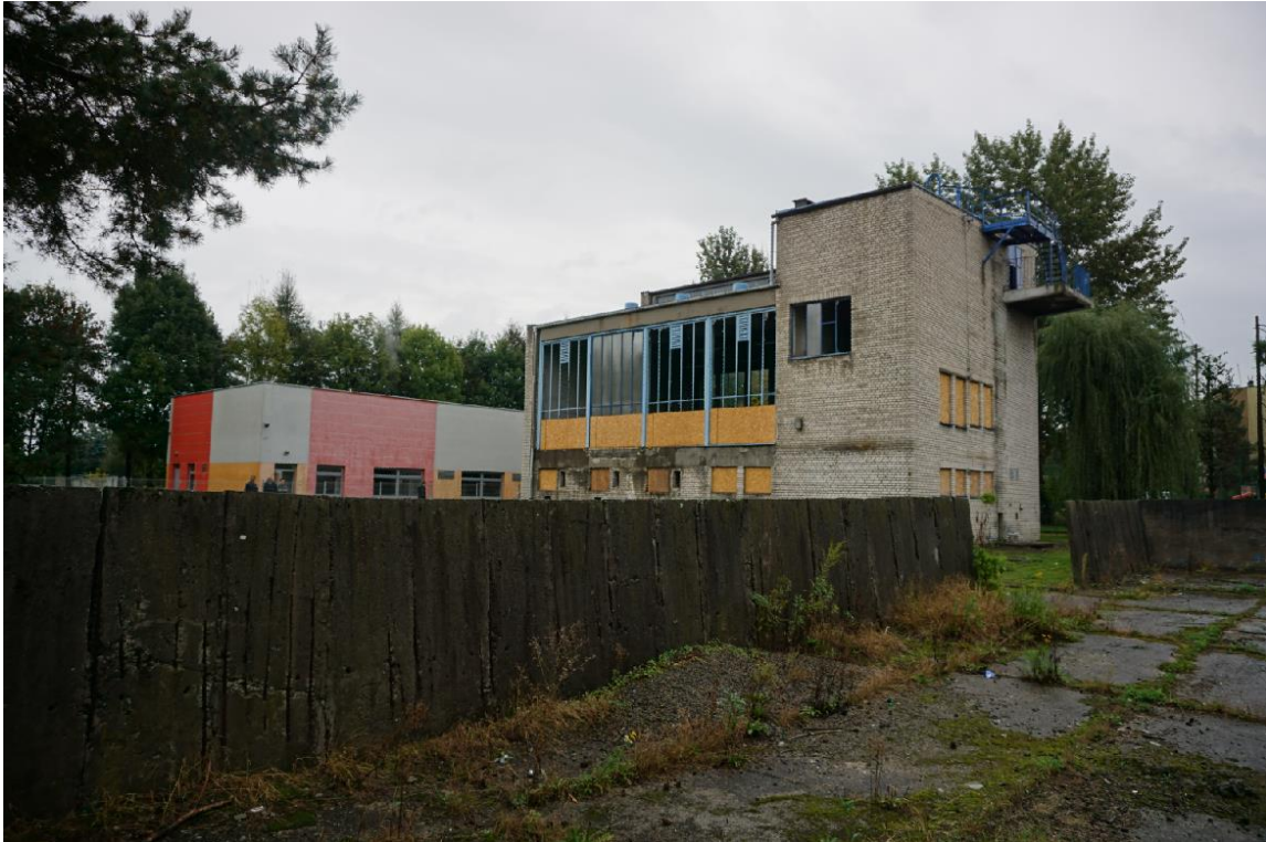
Łączny widok na kotłownię węglową oraz w tle – kotłownię GO (widok od strony północno-zachodniej)
