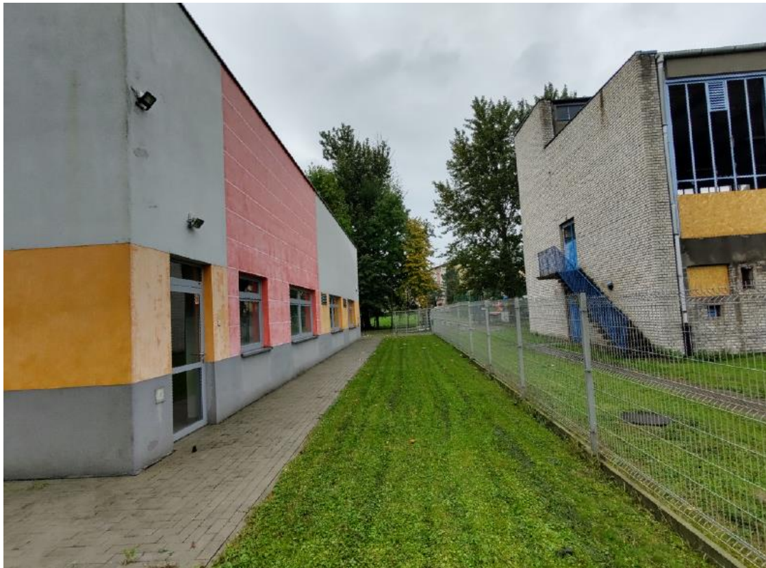
Widok od strony północno-wschodniej – widoczne ogrodzenie rozdzielające kotłownię GO od starej kotłowni węglowej
