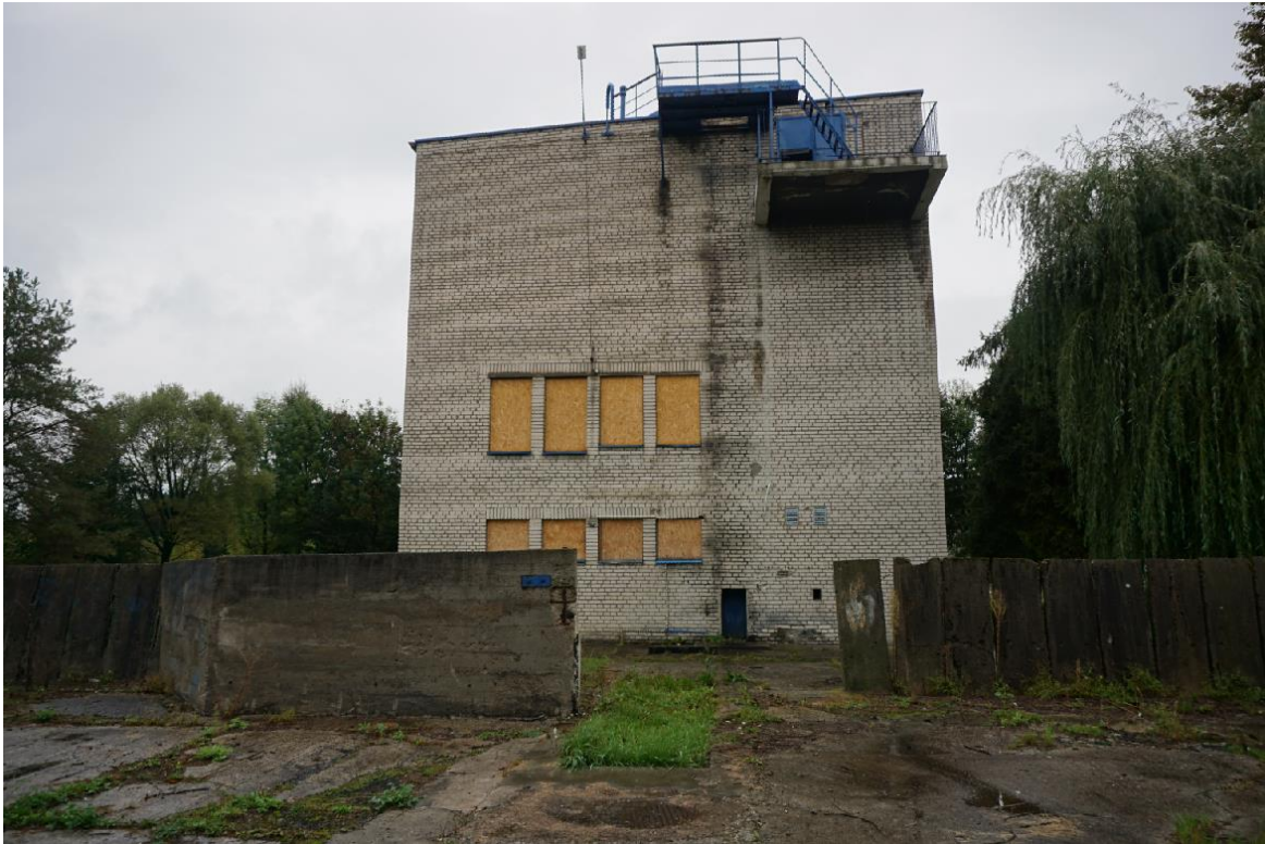
Widok na nieczynną kotłownię węglową przeznaczoną obecnie do rozbiórki
