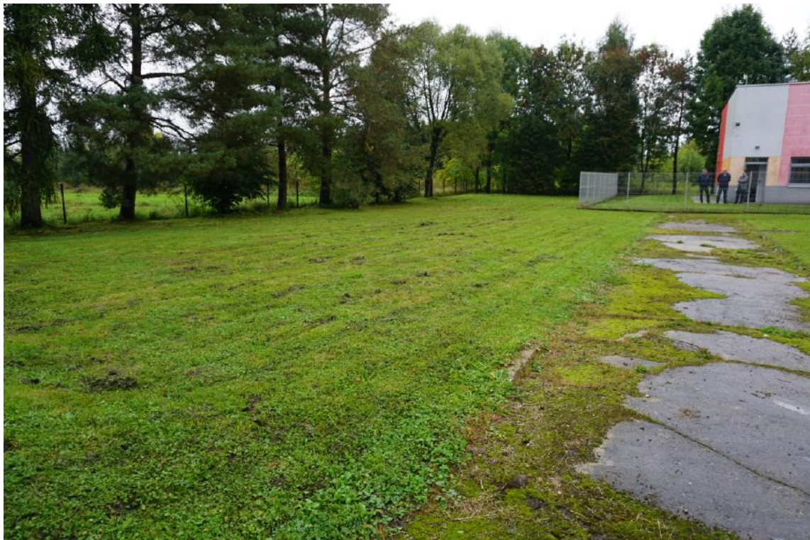
Widok na kotłownię GO (od strony zachodniej)
