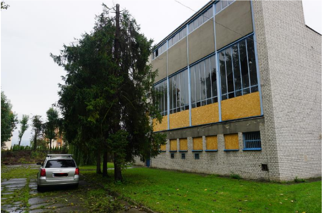
Widok na nieczynną kotłownię węglowa od strony południowo-wschodniej
