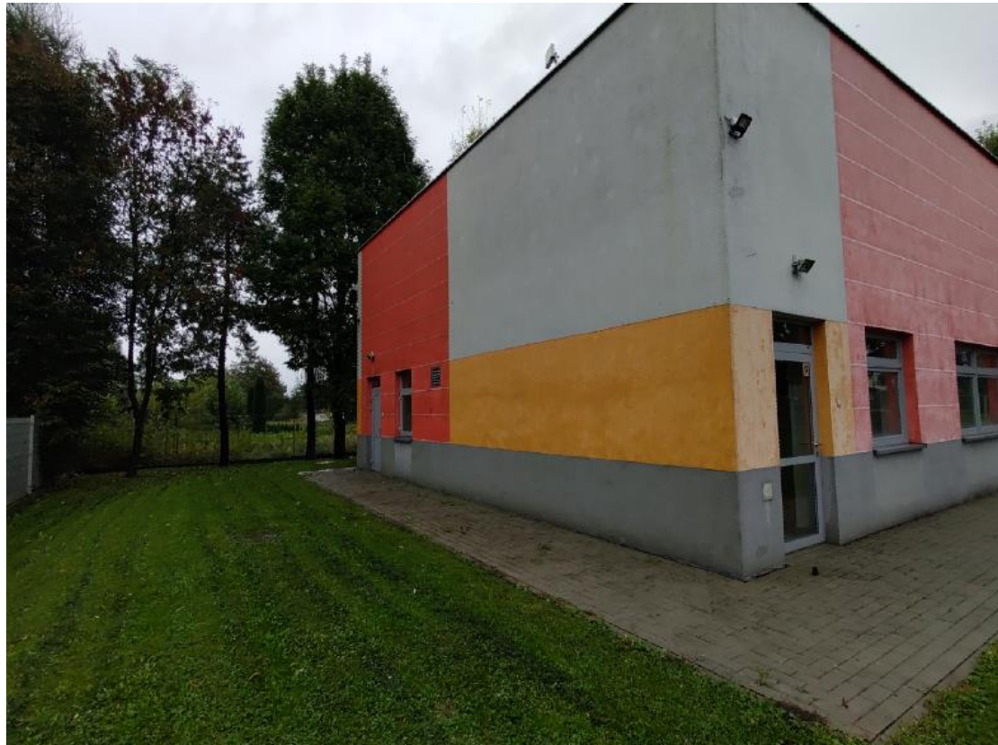
Tylna elewacja kotłowni GO (północna lub północno-zachodnia)
