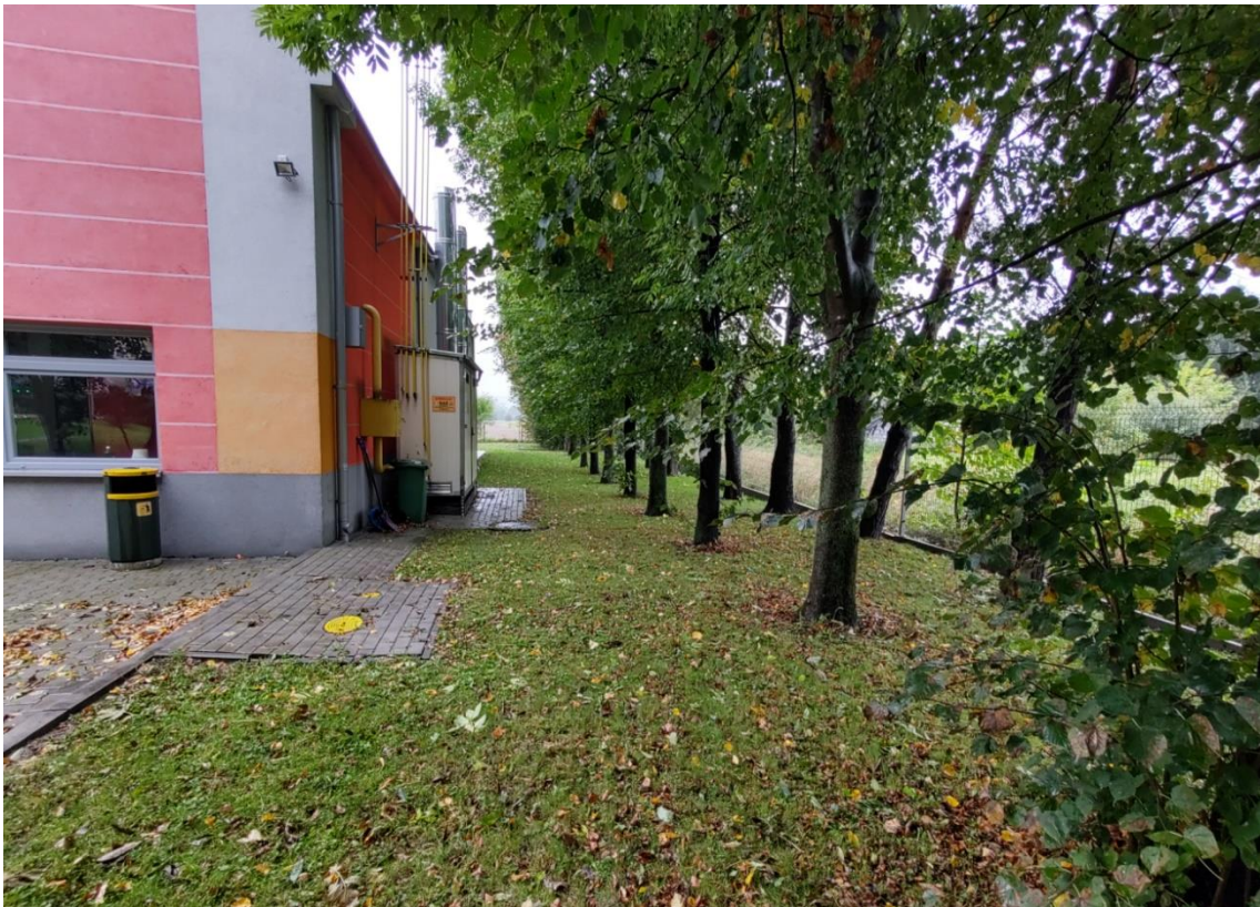
Widok na wschodnią granicę nieruchomości, po stronie lewej – kotłownia GO
