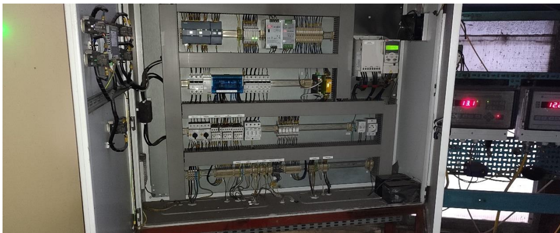
Zdjęcie 4. Szafa sterownicza instalacji odpylania kotła nr 2.
